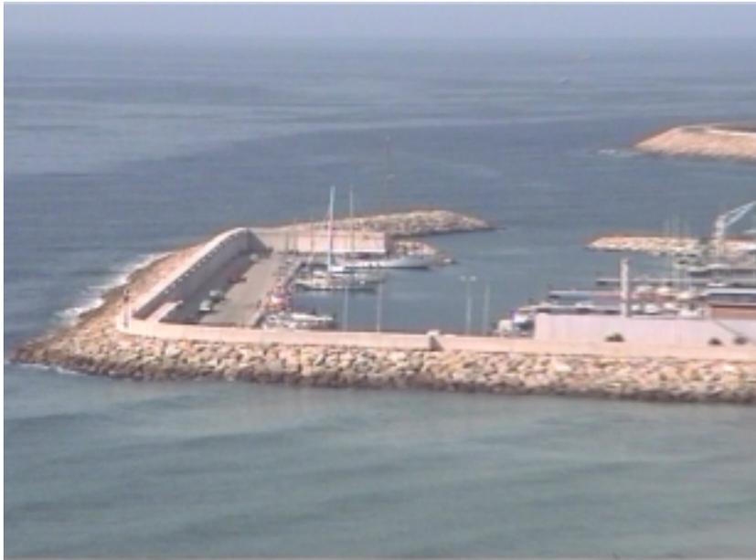
**Raue Bruchstein-Böschungstruktur (Rubble Mound Structure)**
