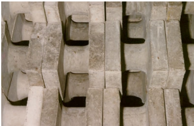
Abb.08: Großformatige Hohlformkörper bilden in Stapelbauweise eine Böschungsneigung 1: n = 1: 2.
