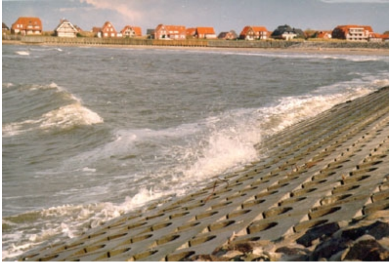
Abb.01: Durchströmbares Böschungsdeckwerk der Neigung 1: n = 1: 3, Flächengewicht 5 kN/m 2 ; Baltrum 1992
